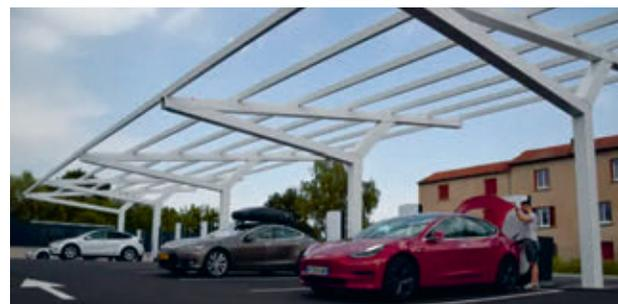
D'une puissance de 250 kW chacune, 12 bornes, alimentées par une ombrière, permettent de recharger jusqu'à 322 km en 15 minutes.
