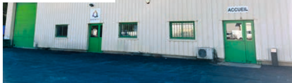
L'entrepôt d'Entrepro a été agrandi au cours des derniers mois.
