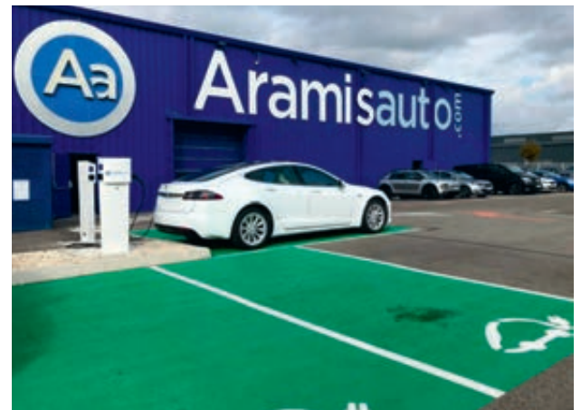
AramisAuto anticipe la progression des véhicules électriques sur le marché de l'occasion : il installe des bornes et forme ses équipes.
