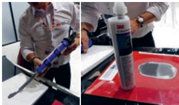
Après ponçage (disque P80-P120), l'épaisseur maximale de la couche appliquée de mastic ne doit pas dépasser 2-3 mm.
