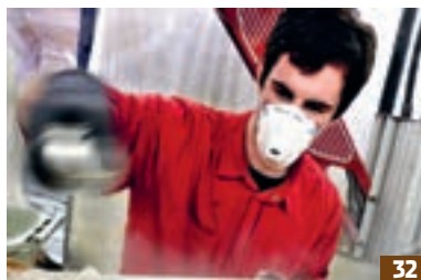
Le spot repair dans les règles de l'art
