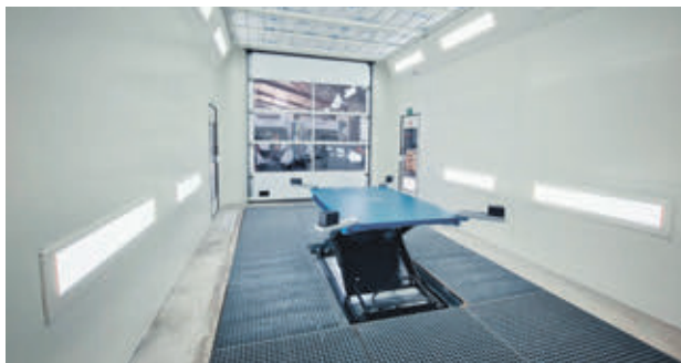
Les cabines récentes sont de plus en plus équipées d'une table élévatrice pour que le peintre puisse pistoler partout à hauteur d'homme.
